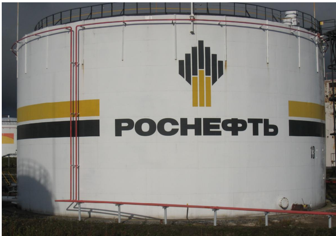
Рисунок 1 - Общий вид резервуара стального вертикального цилиндрического РВС-5000
