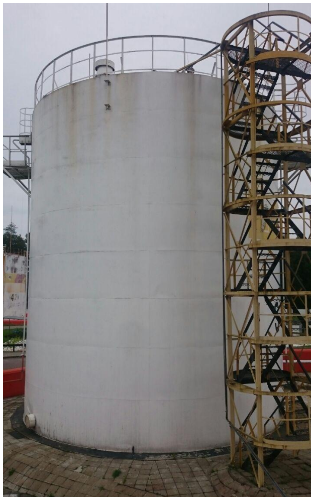
Рисунок 1 - Общий вид резервуара стального вертикального цилиндрического РВС-1000
