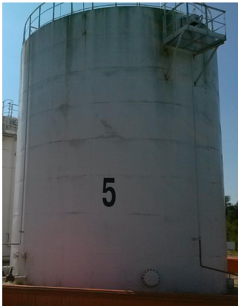
Рисунок 1 - Общий вид резервуара стального вертикального цилиндрического РВС-1000
