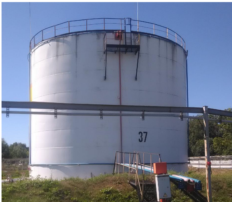
Рисунок 1 - Общий вид резервуара РВС-2000 №37
