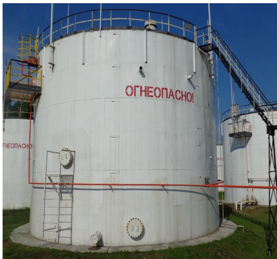
Рисунок 2 - Общий вид резервуара стального вертикального цилиндрического РВС-5000
