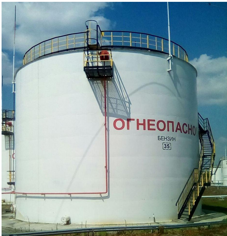
Рисунок 1 - Общий вид резервуара стального вертикального цилиндрического РВС-2000
