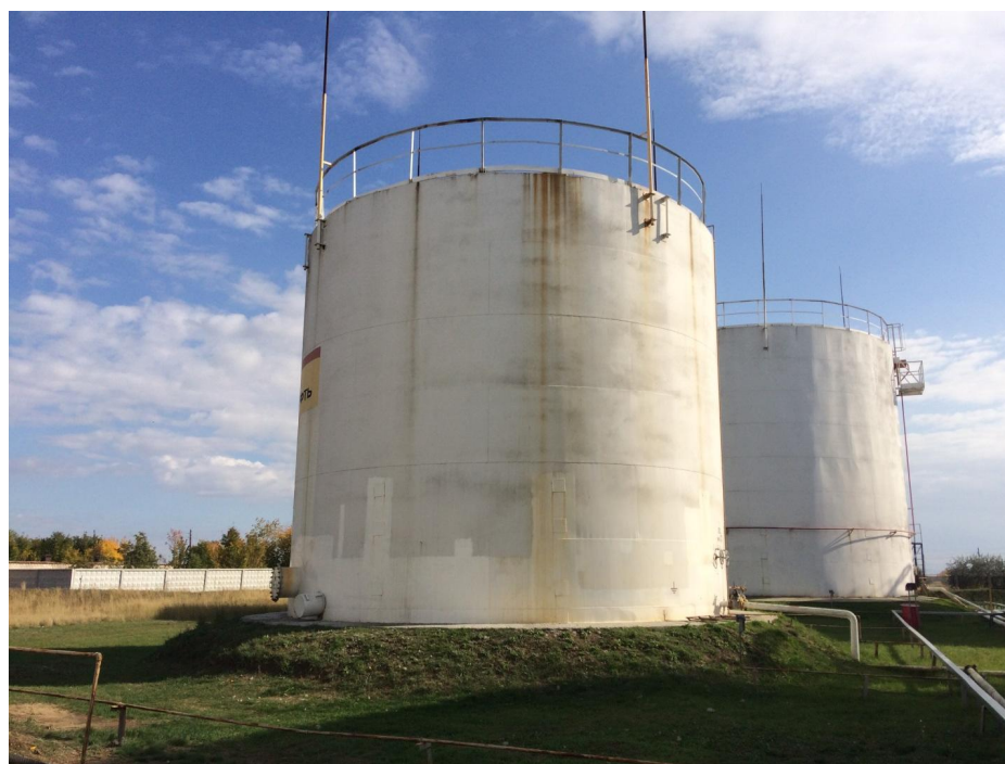
Рисунок 3 - Общий вид резервуара стального вертикального цилиндрического РВС-700
