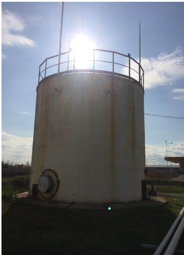
Рисунок 1 - Общий вид резервуара стального вертикального цилиндрического РВС-200
