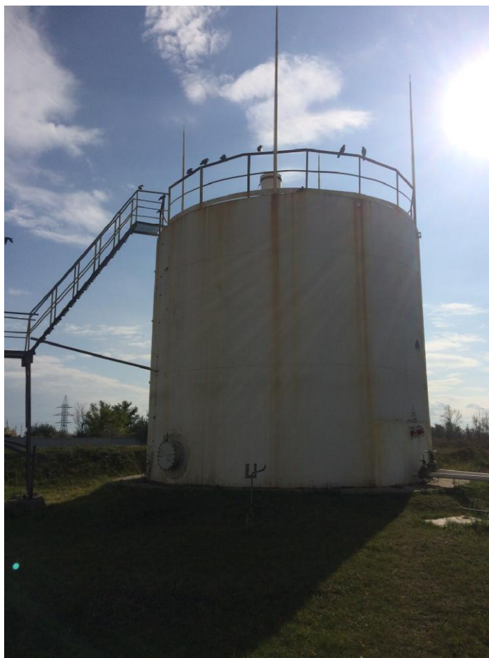
Рисунок 2 - Общий вид резервуара стального вертикального цилиндрического РВС-400
