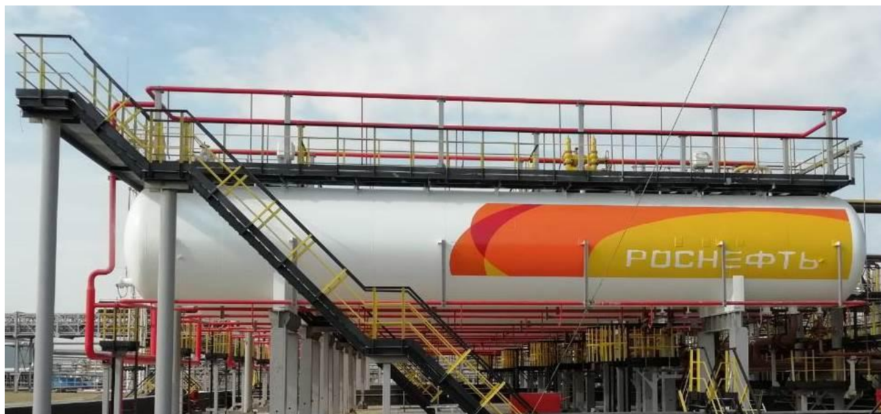
Рисунок 1 - Общий вид резервуара стального горизонтального цилиндрического РГС-200
