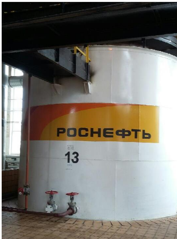
Рисунок 1 - Общий вид резервуара стального вертикального цилиндрического РВС-100
