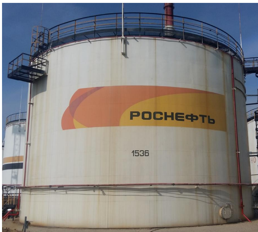
Рисунок 5 - Общий вид резервуара стального вертикального цилиндрического РВС-3000
