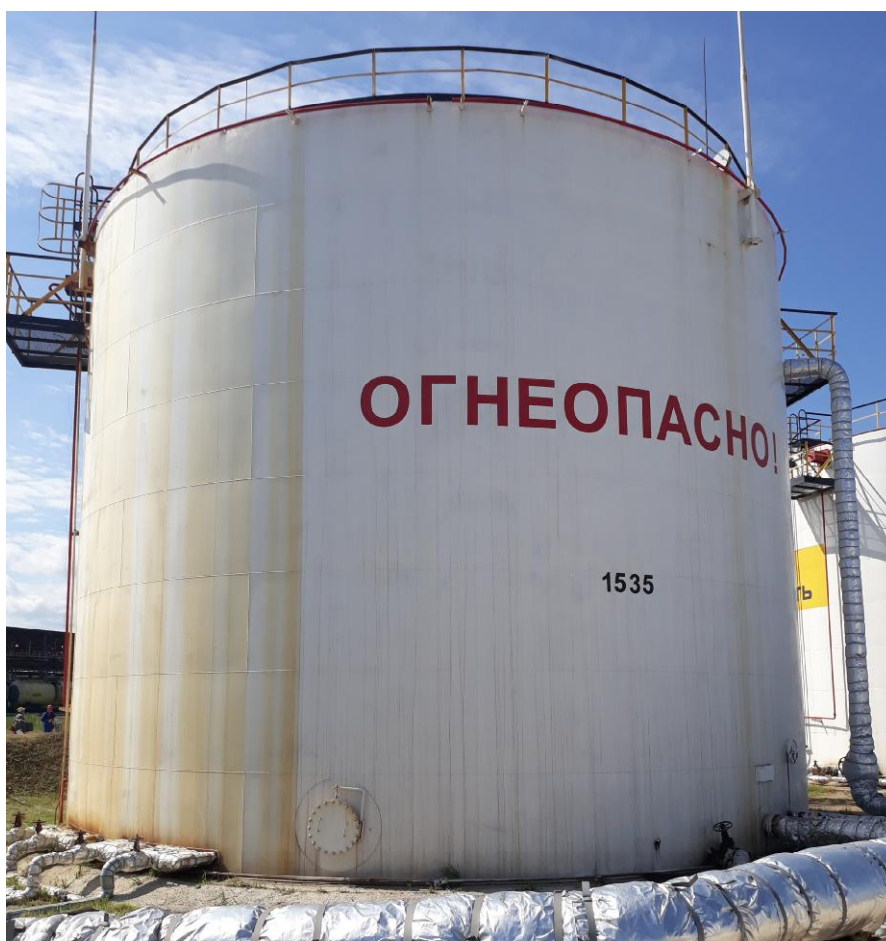
Рисунок 4 - Общий вид резервуара стального вертикального цилиндрического РВС-2000
