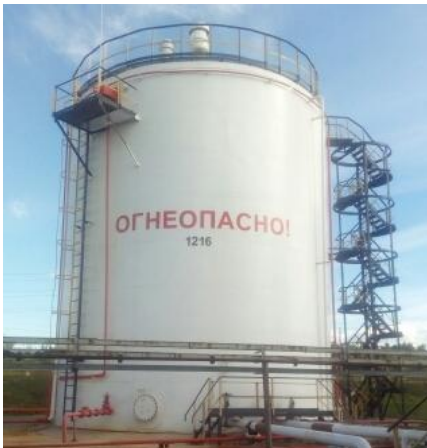
Рисунок 3 - Общий вид резервуара стального вертикального цилиндрического РВС-1000
