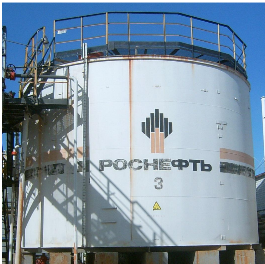
Рисунок 2 - Общий вид резервуара стального вертикального цилиндрического РВС-400
