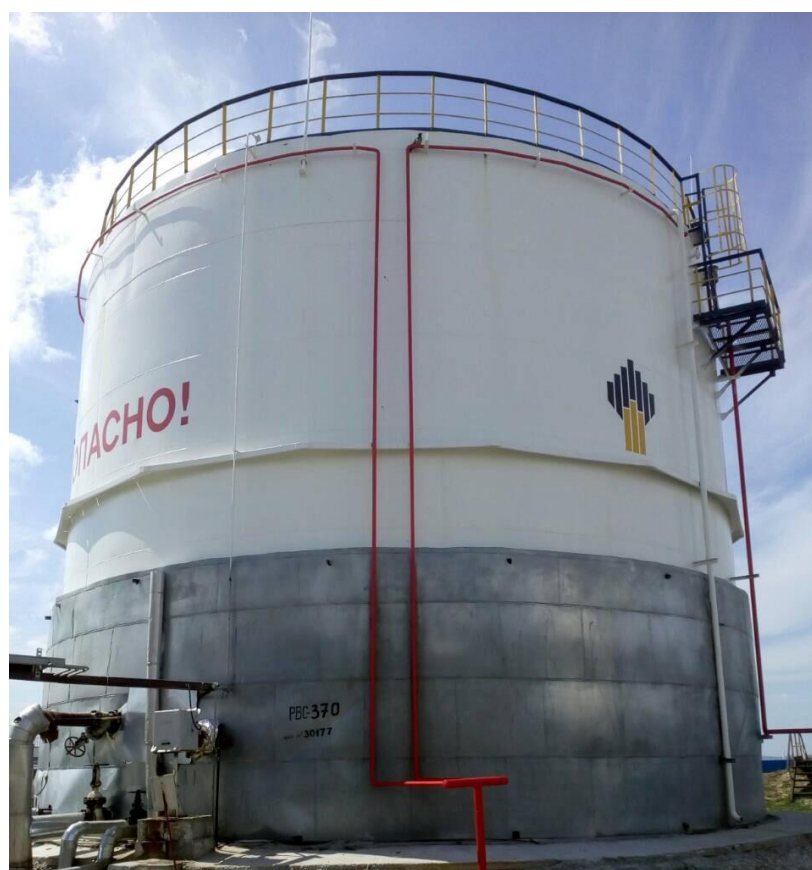
Рисунок 3 - Общий вид резервуара стального вертикального цилиндрического РВС-2000
