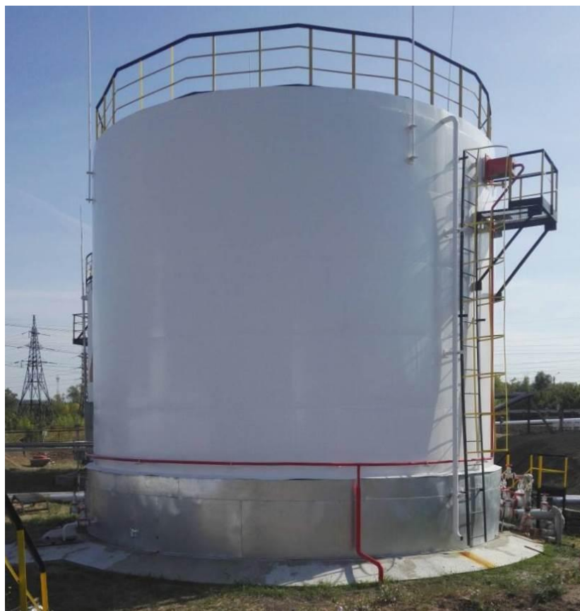
Рисунок 2 - Общий вид резервуара стального вертикального цилиндрического РВС-700
