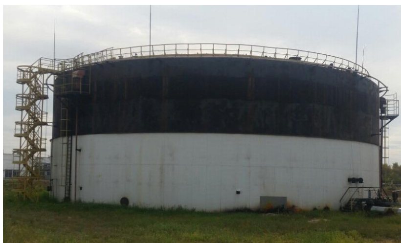
Рисунок 5 - Общий вид резервуара стального вертикального цилиндрического РВС-10000
