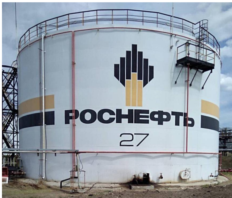
Рисунок 4 - Общий вид резервуара стального вертикального цилиндрического РВС-5000
