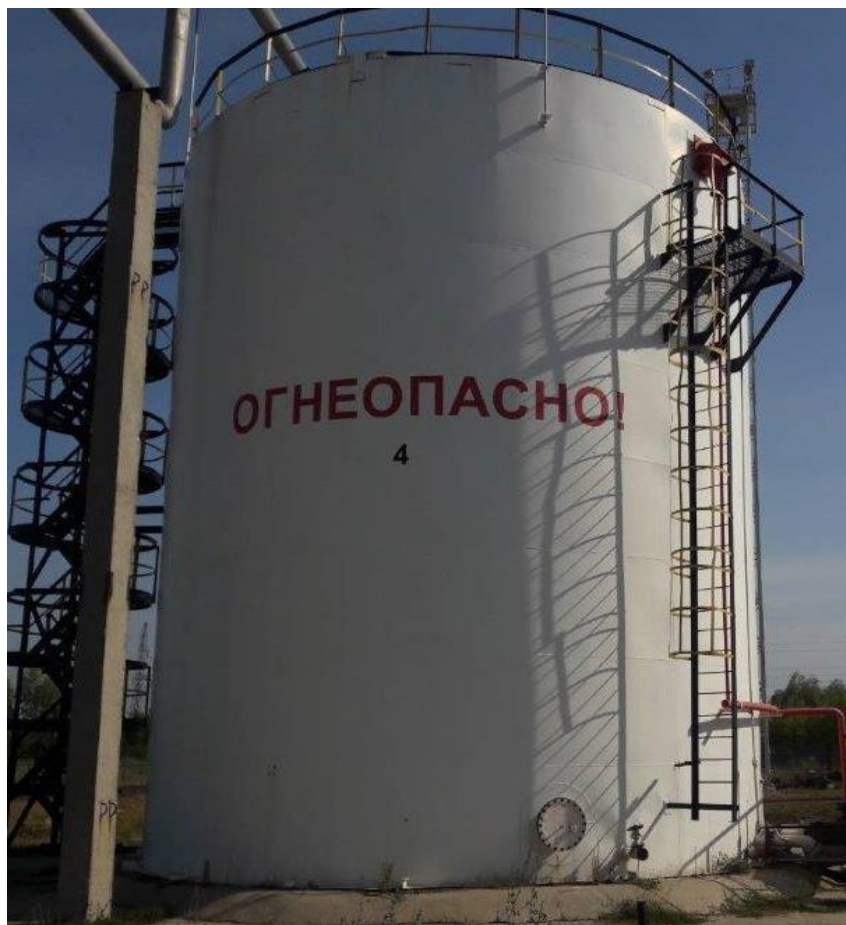
Рисунок 1 - Общий вид резервуара стального вертикального цилиндрического РВС-1000
