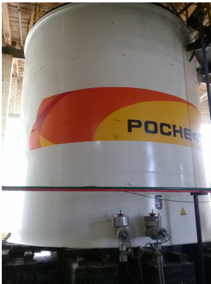
Рисунок 2 - Общий вид резервуара стального вертикального цилиндрического PVC-200
