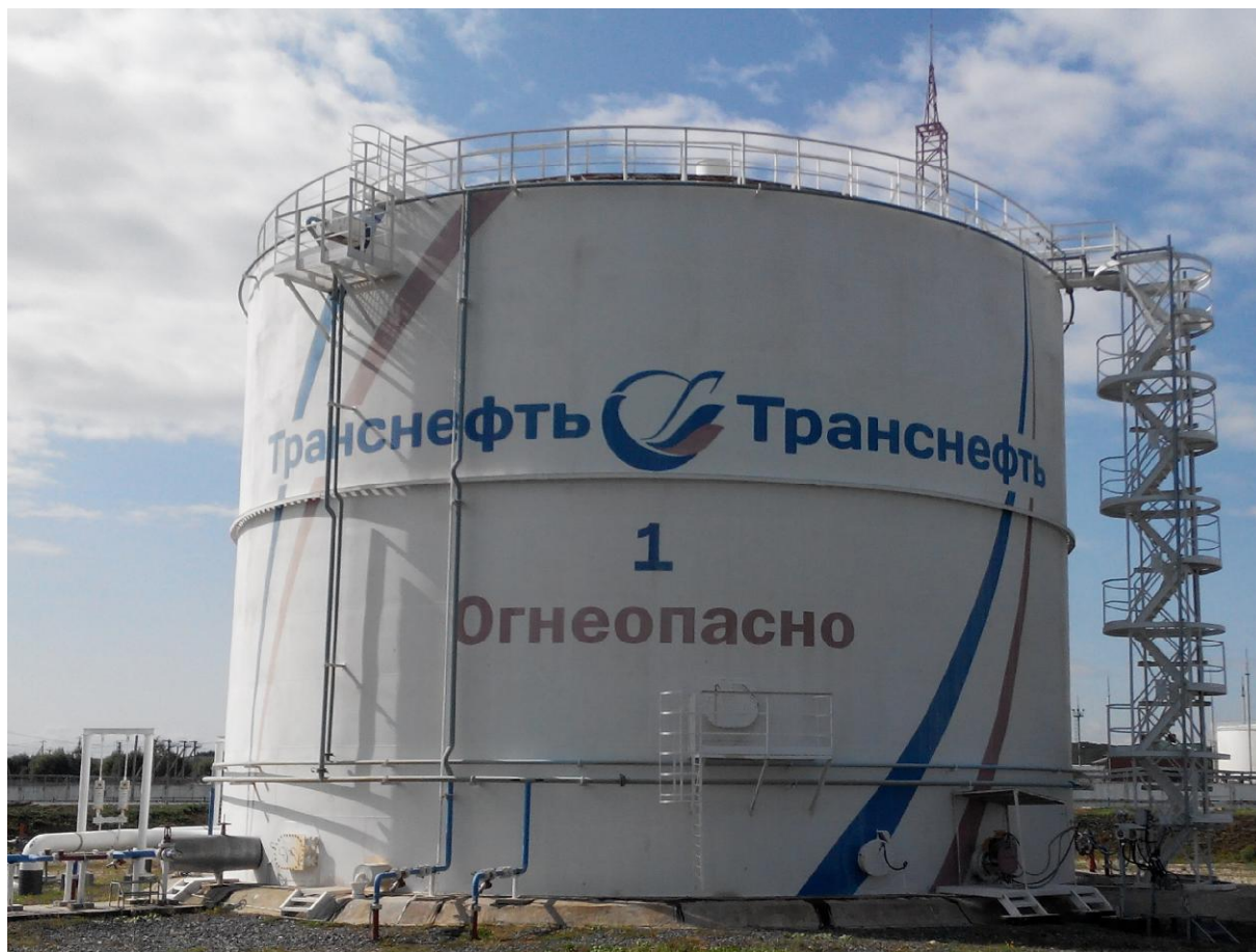
Рисунок 1 - Общий вид резервуаров вертикальных стальных цилиндрических РВСП-5000
