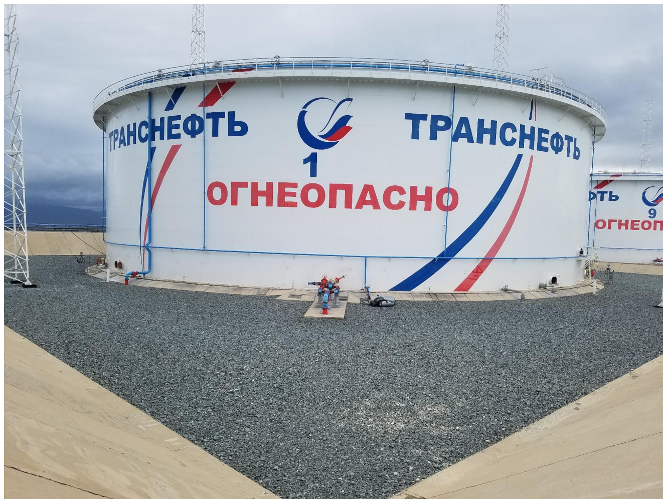
Рисунок 2 - Общий вид резервуара вертикального стального цилиндрического РВСПК-50000
