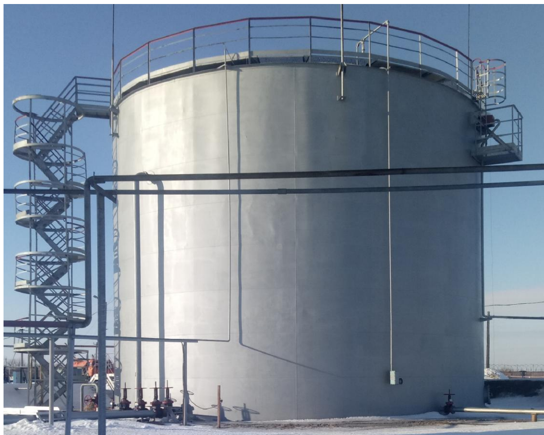
Рисунок 1 - Резервуар вертикальный стальной РВС-2000
