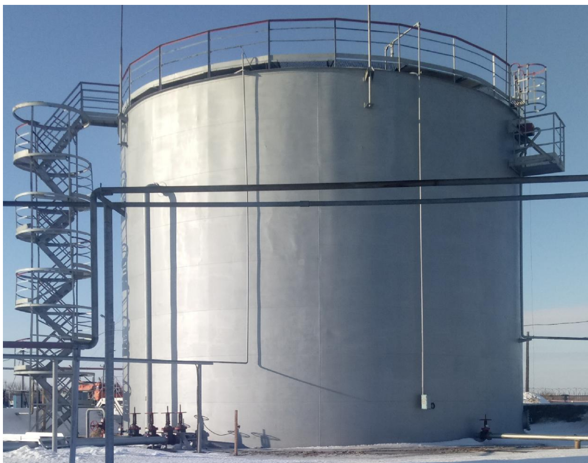
Рисунок 1 - Резервуар вертикальный стальной РВС-2000
