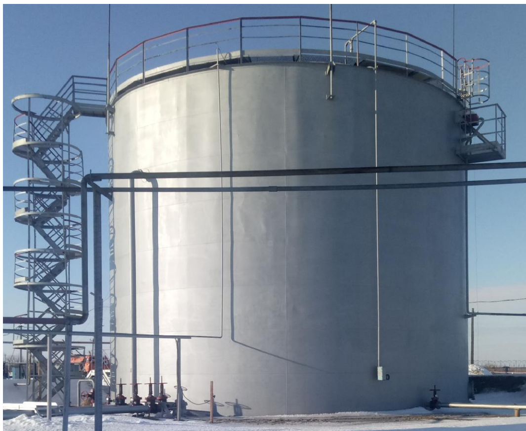
Рисунок 2 - Резервуар вертикальный стальной РВС-2000
