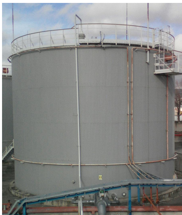
Рисунок 2 - Общий вид резервуаров вертикальных стальных РВС-2000 зав. №№ 9, 10, 11
