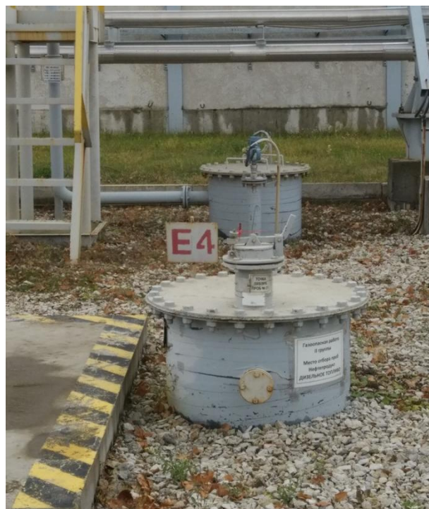
Рисунок 2 - Общий вид видимых частей конструкции резервуаров РГС-40 № Еп-3 (слева), № Еп-4 (справа)
