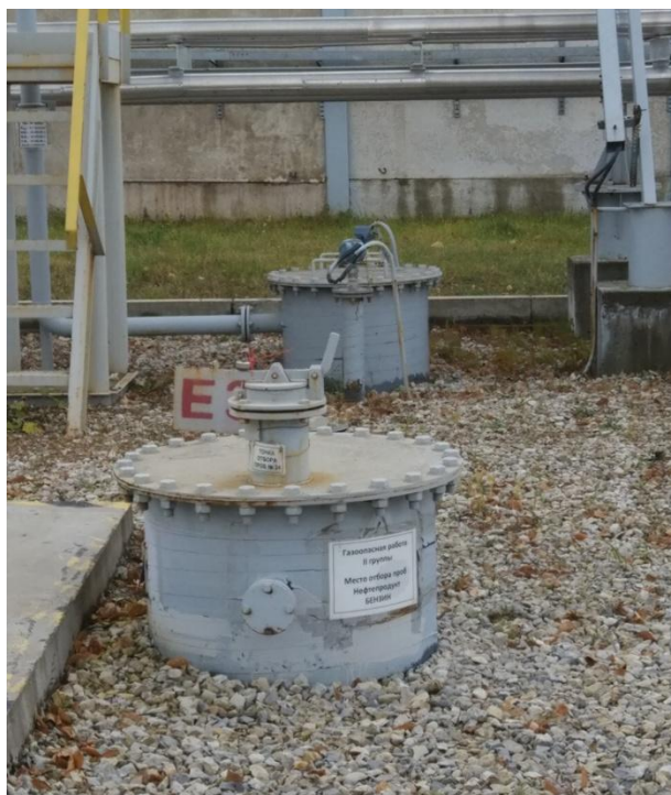
Рисунок 2 - Общий вид видимых частей конструкции резервуаров РГС-40 № Еп-3 (слева), № Еп-4 (справа)
