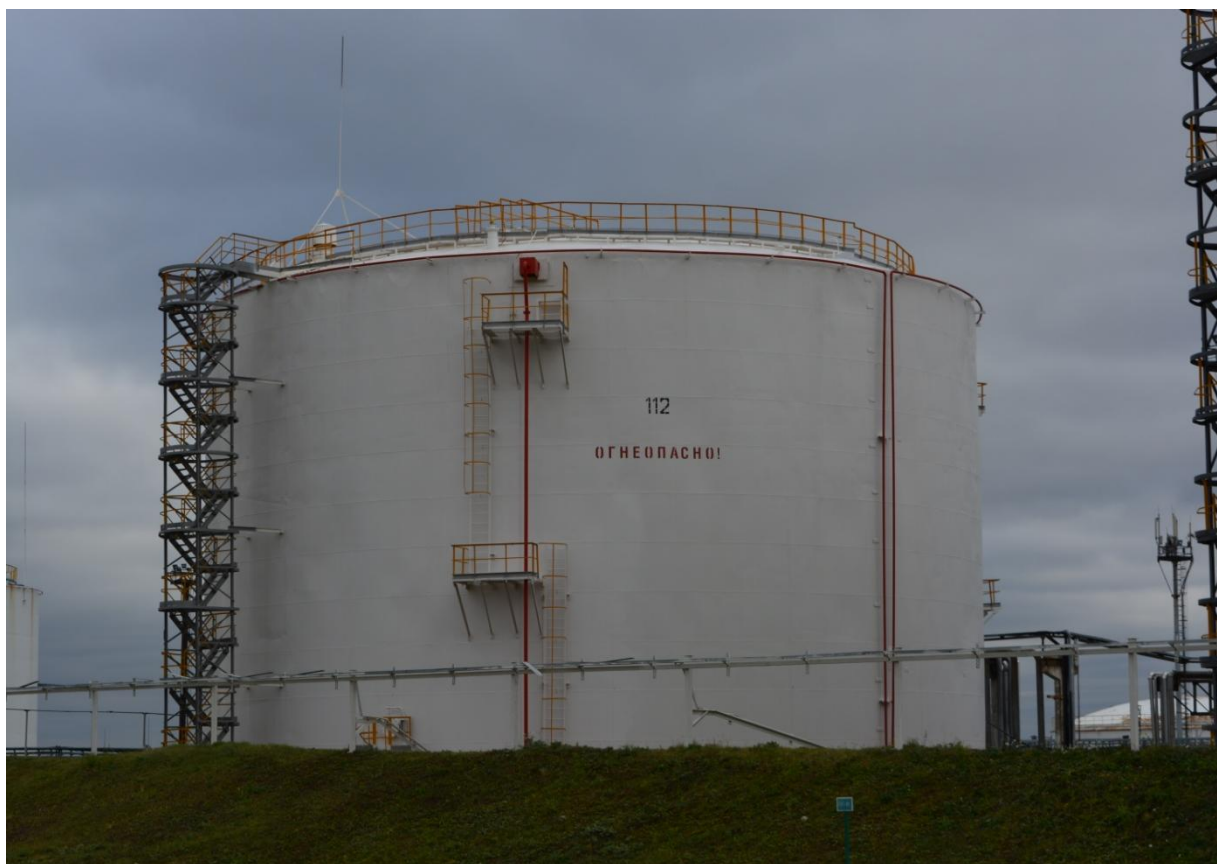
Рисунок 10 - Общий вид резервуара РВСП-10000 № 112
