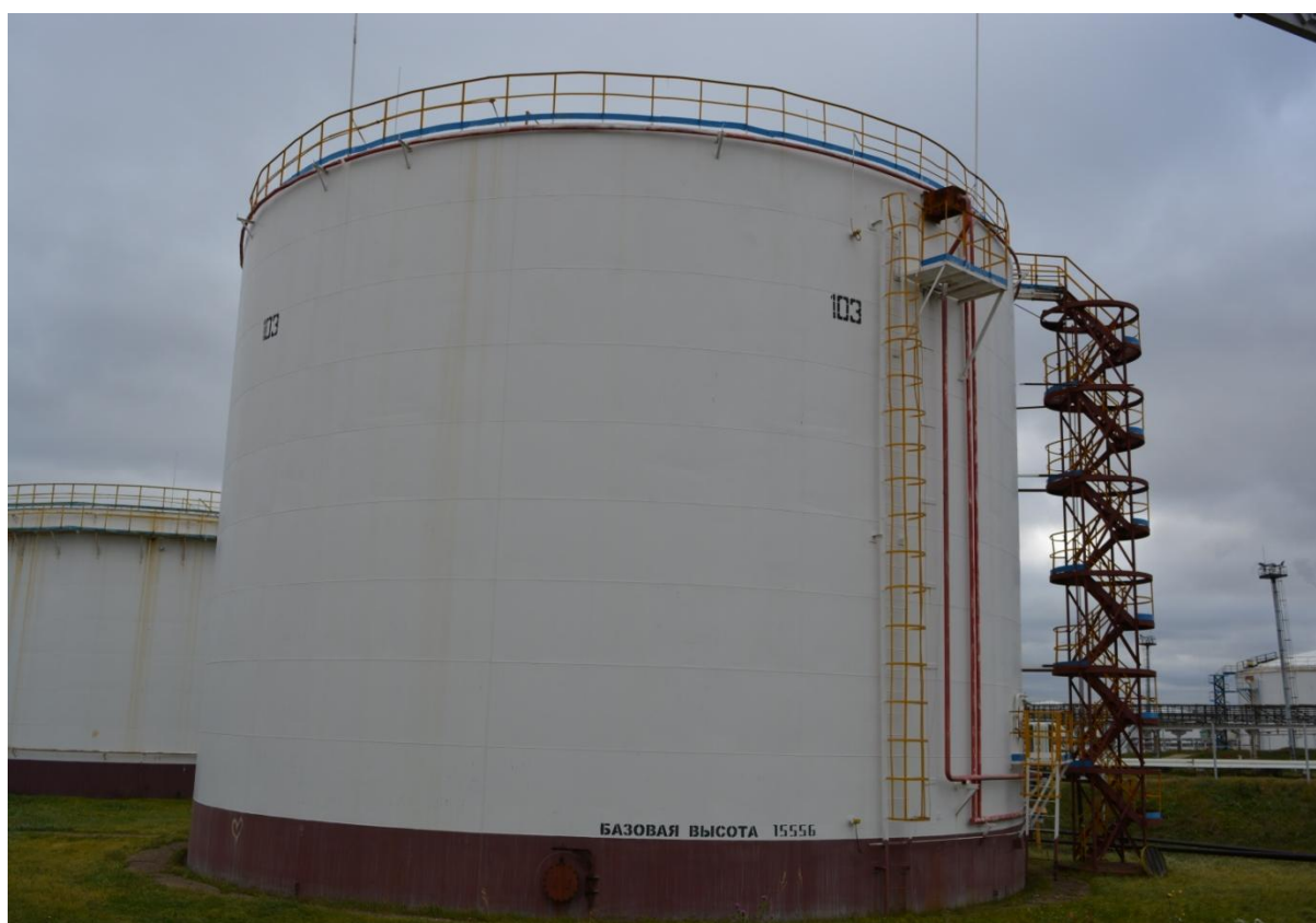
Рисунок 2 - Общий вид резервуара РВСП-5000 № 103
