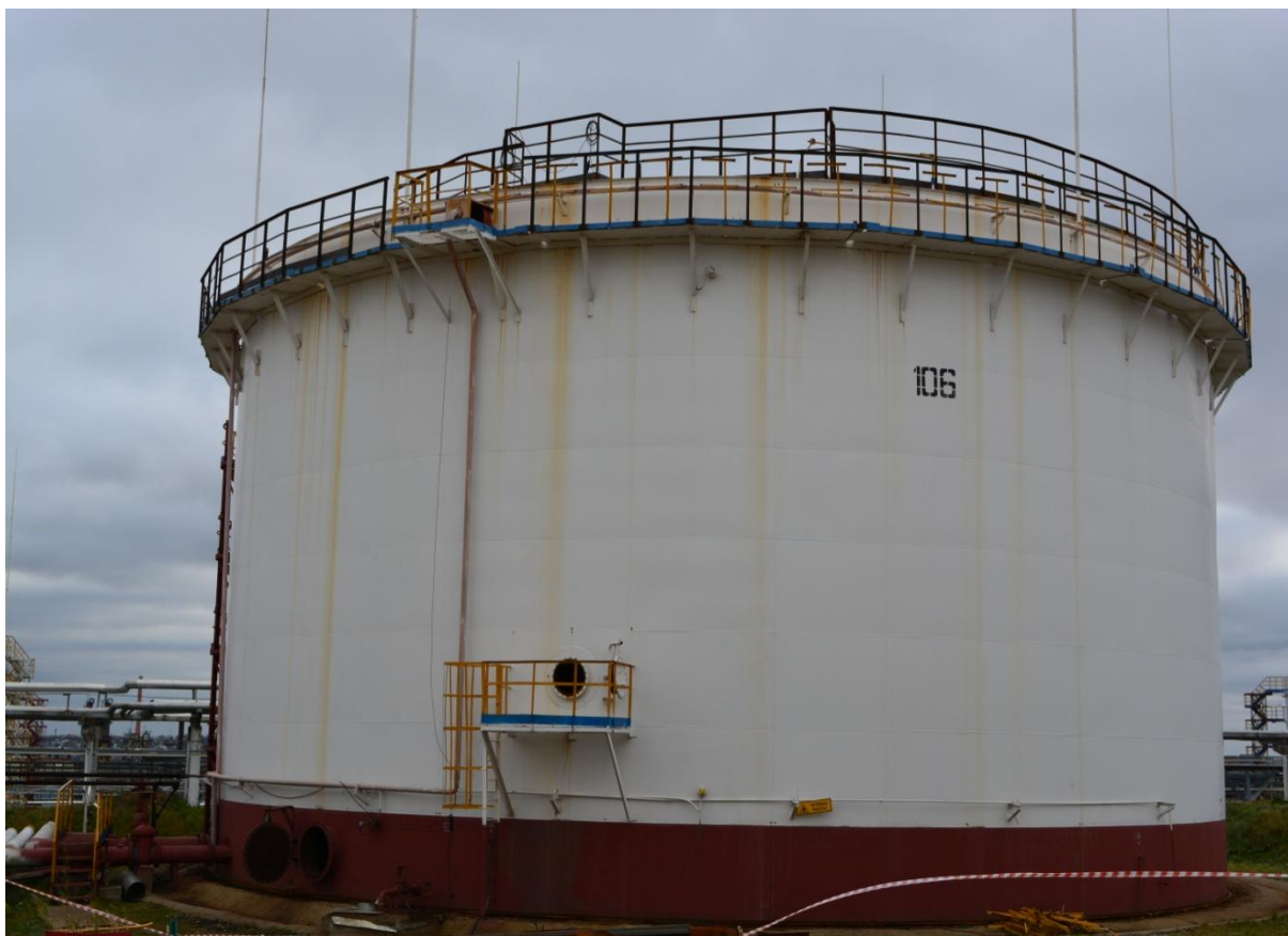
Рисунок 5 - Общий вид резервуара РВСП-5000 № 106
