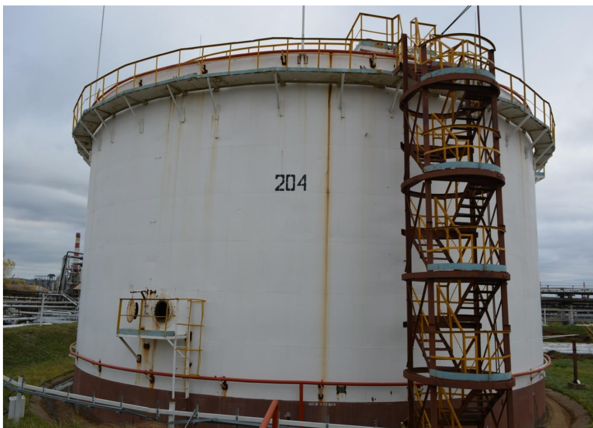
Рисунок 7 - Общий вид резервуара РВСП-5000 № 204
