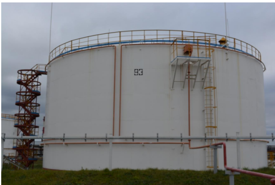
Рисунок 1 - Общий вид резервуара РВСП-5000 № 93
