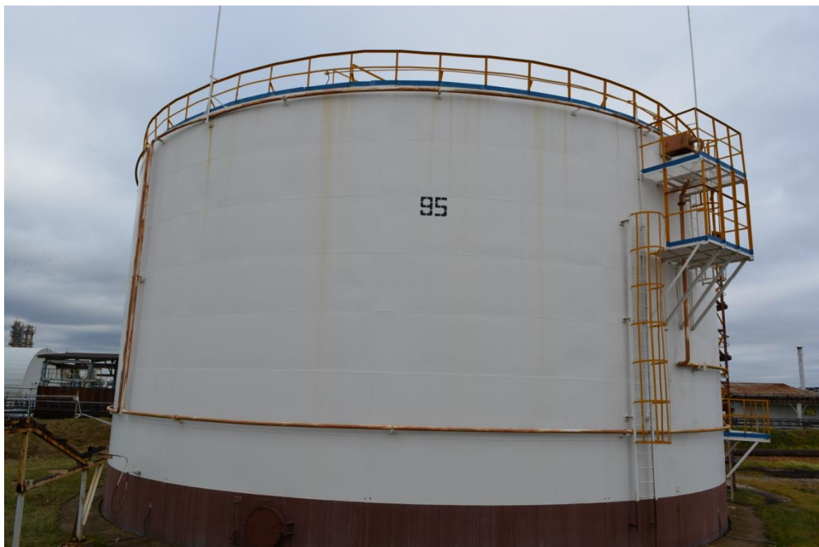
Рисунок 2 - Общий вид резервуара РВСП-5000 № 95
