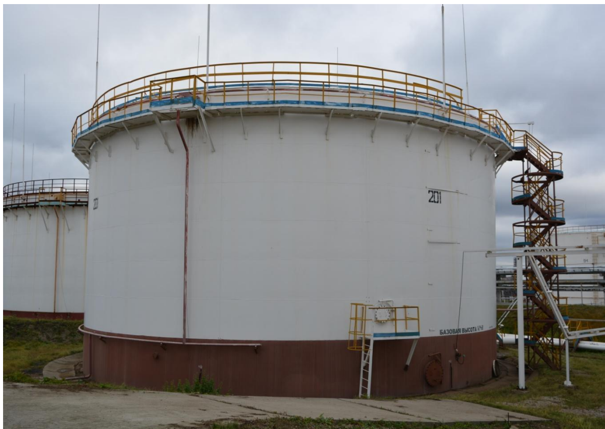
Рисунок 4 - Общий вид резервуара РВСП-5000 №201
