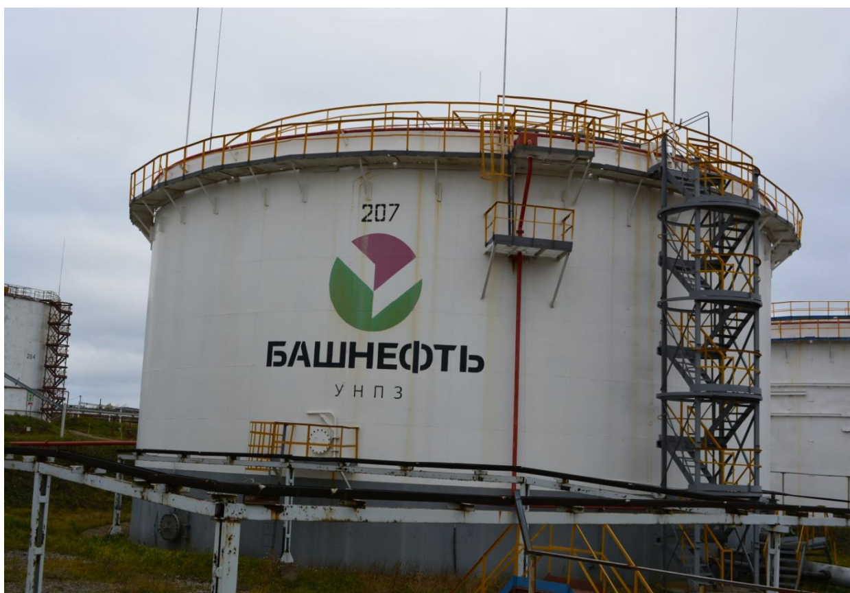
Рисунок 10 - Общий вид резервуара РВСП-5000 № 207
