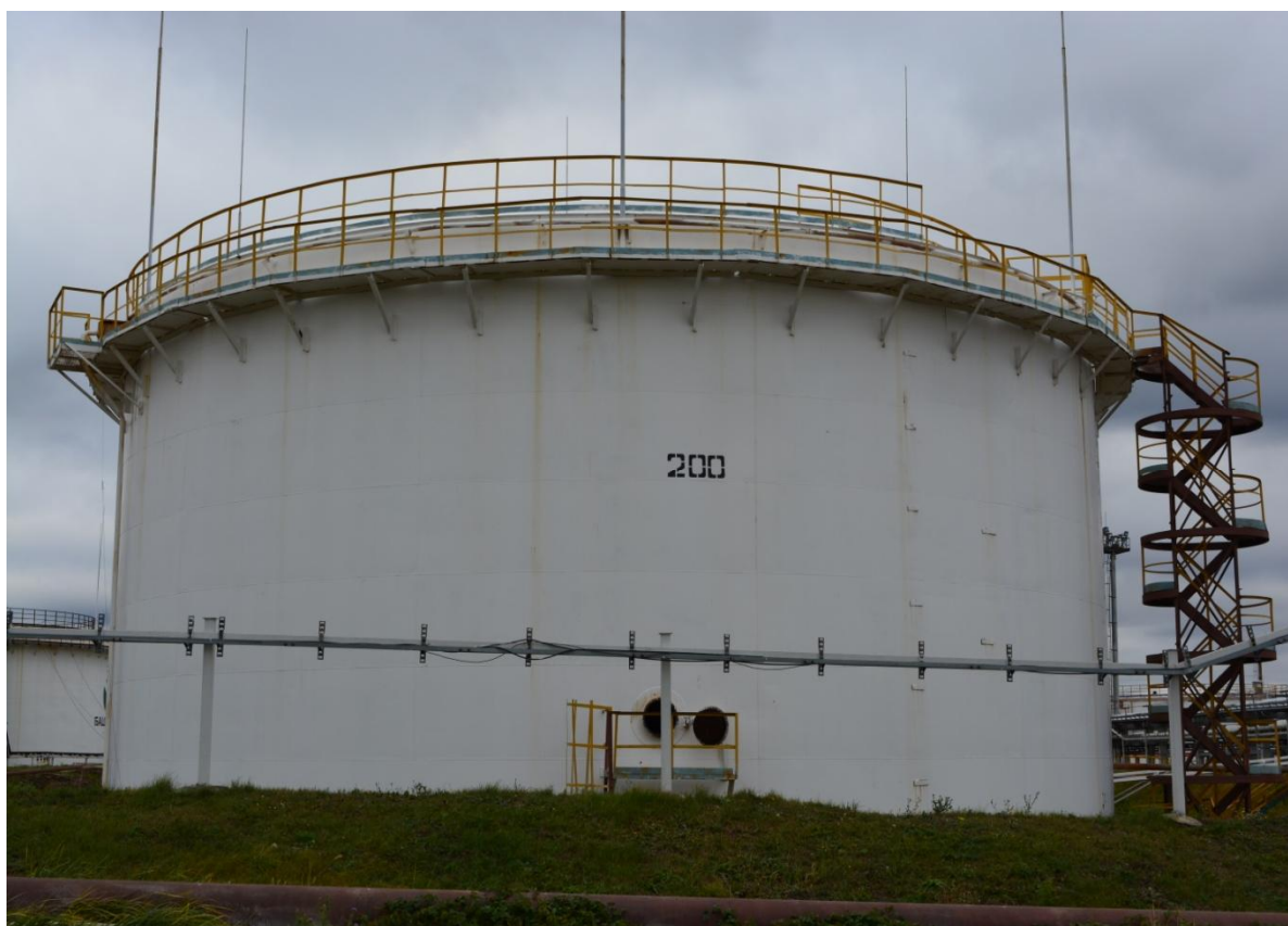
Рисунок 3 - Общий вид резервуара РВСП-5000 № 200
