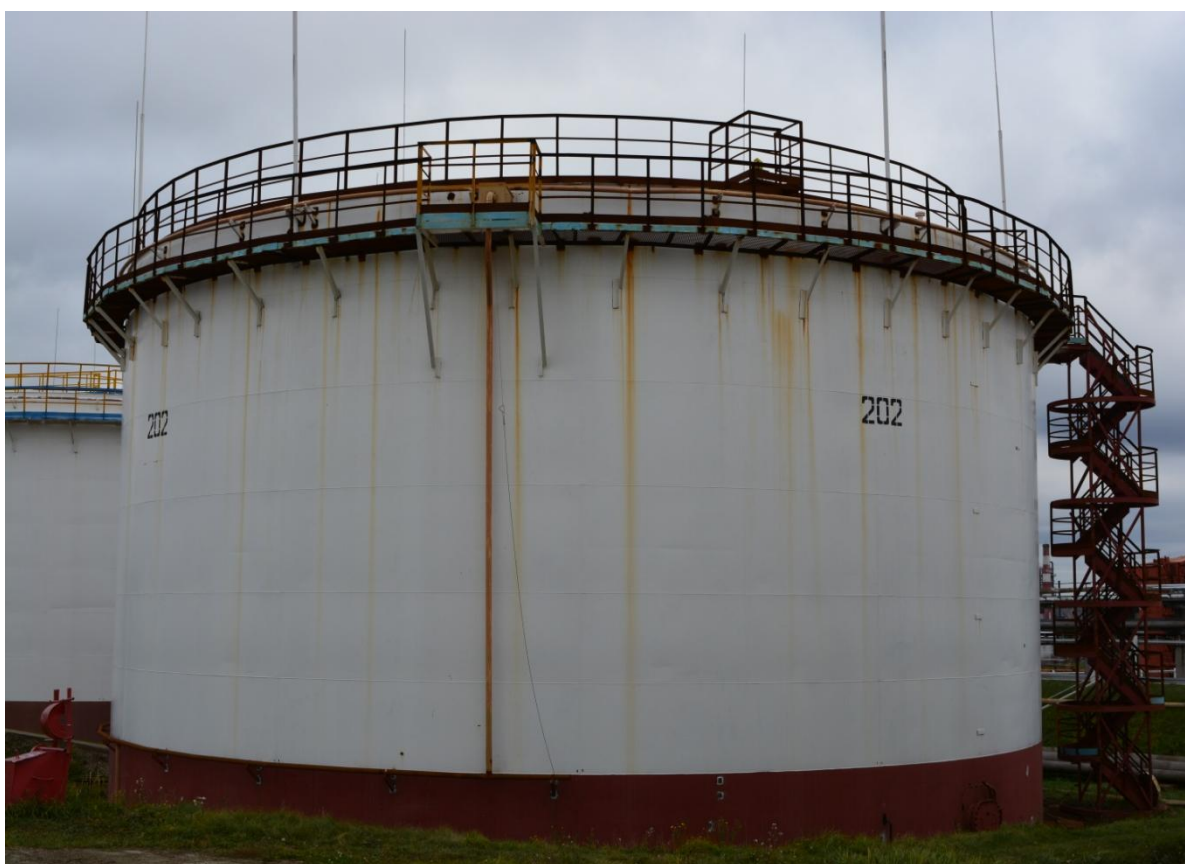
Рисунок 5 - Общий вид резервуара РВСП-5000 № 202
