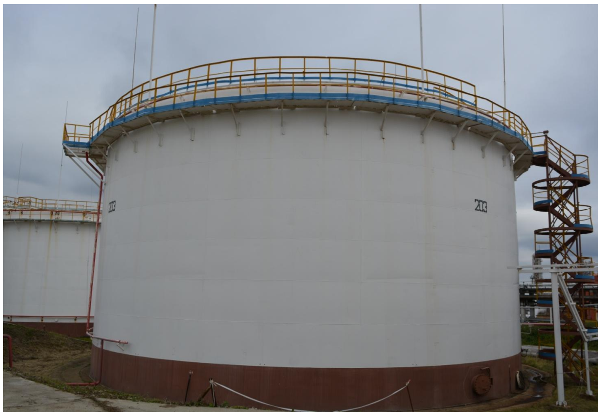
Рисунок 6 - Общий вид резервуара РВСП-5000 № 203
