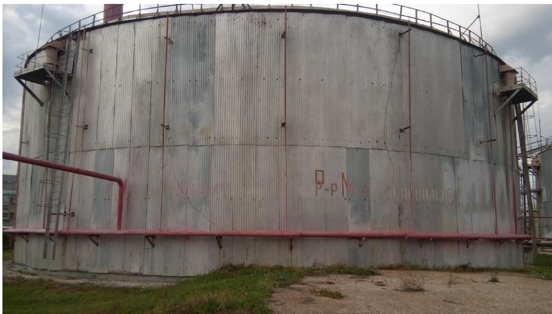
Рисунок 1 - Общий вид резервуара стального вертикального цилиндрического РВС-10000 № 2
