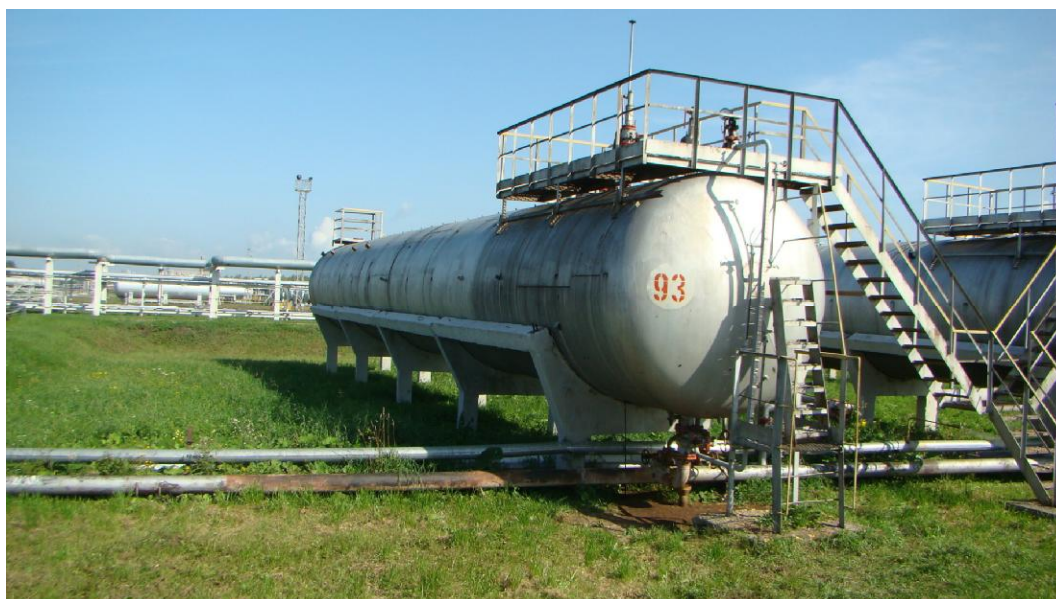
Рисунок 1 - Общий вид резервуаров стальных горизонтальных цилиндрических РГС-175
