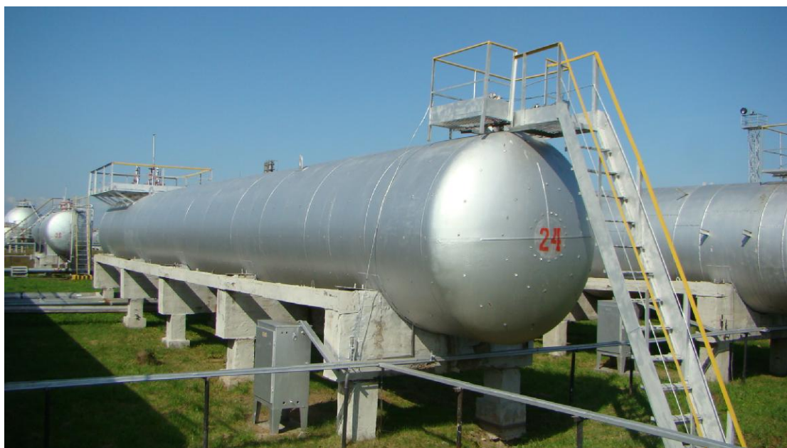
Рисунок 1 - Общий вид резервуаров стальных горизонтальных цилиндрических РГС-175
