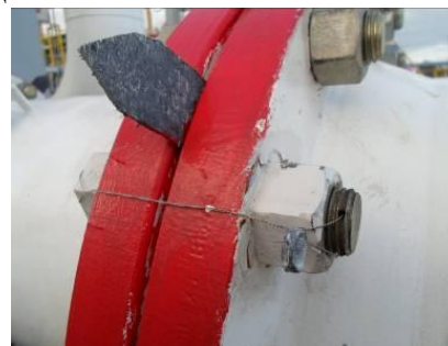
Рисунок 2 – Места установки пломб на ТПР
