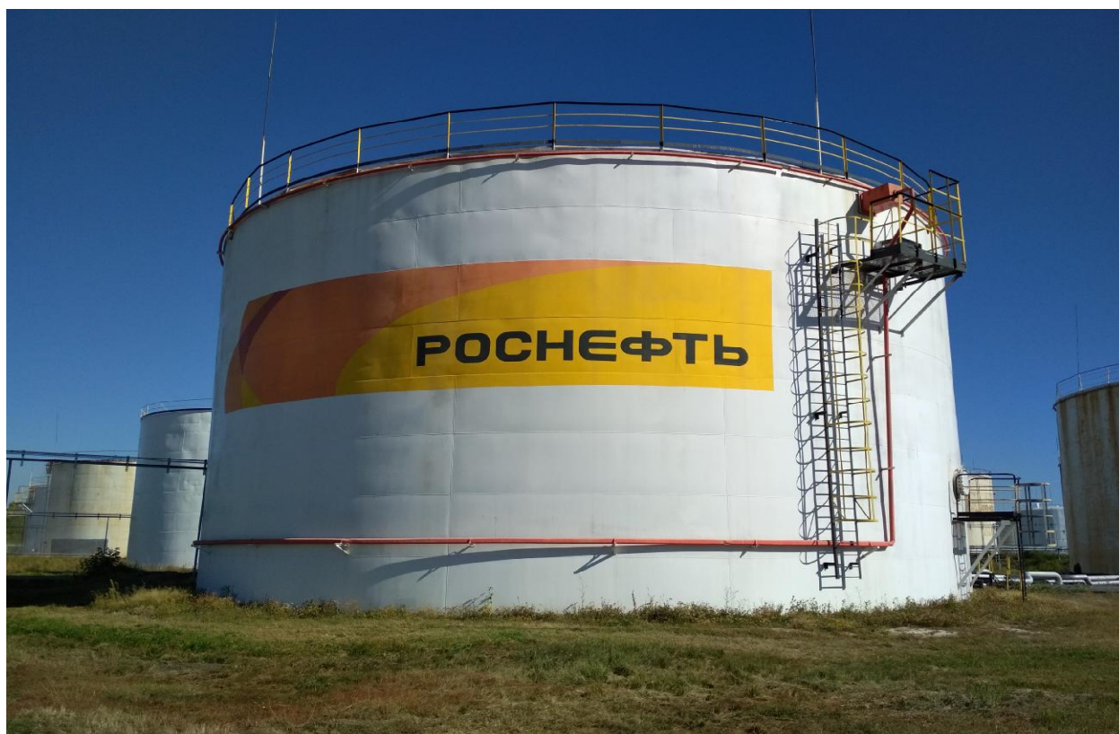
Рисунок 2- Общий вид резервуара вертикального стального цилиндрического РВС-5000 № 5
