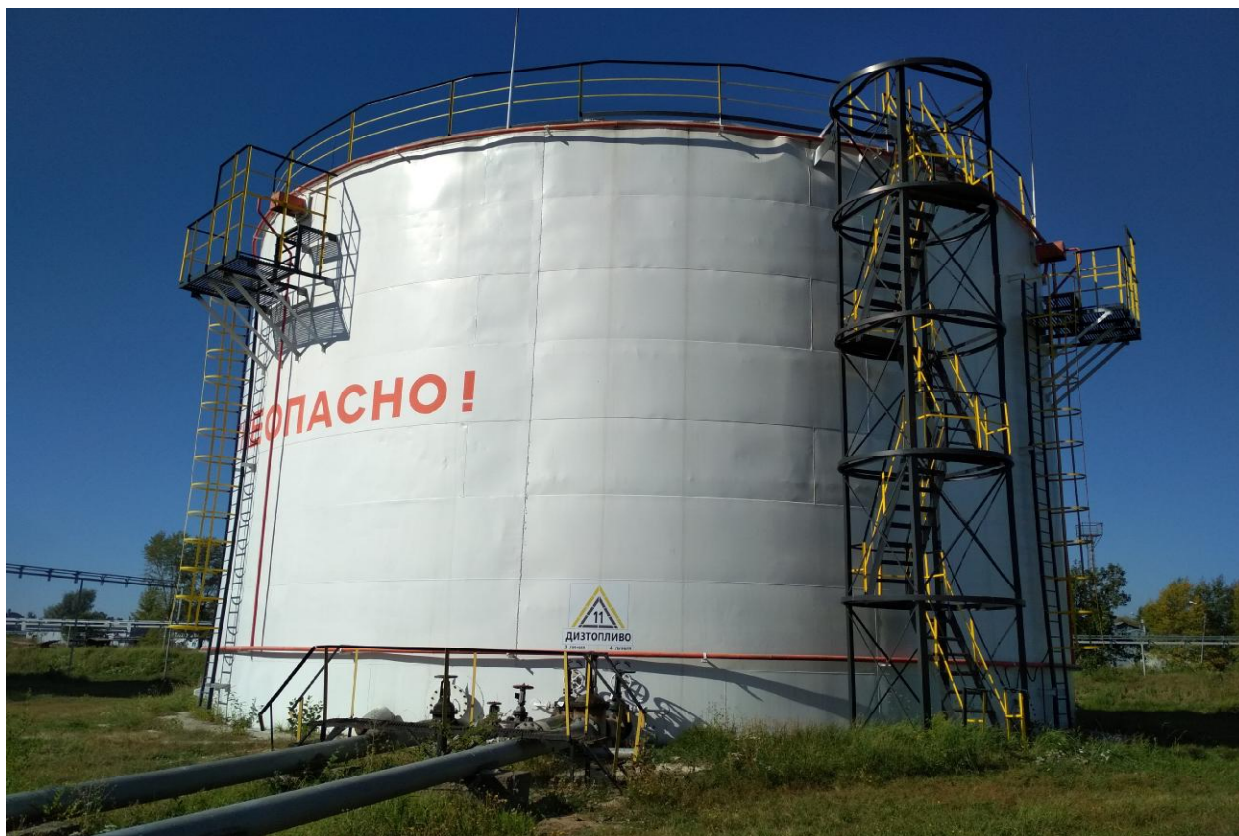
Рисунок 1 - Общий вид резервуара вертикального стального цилиндрического РВС-3000 № 11
