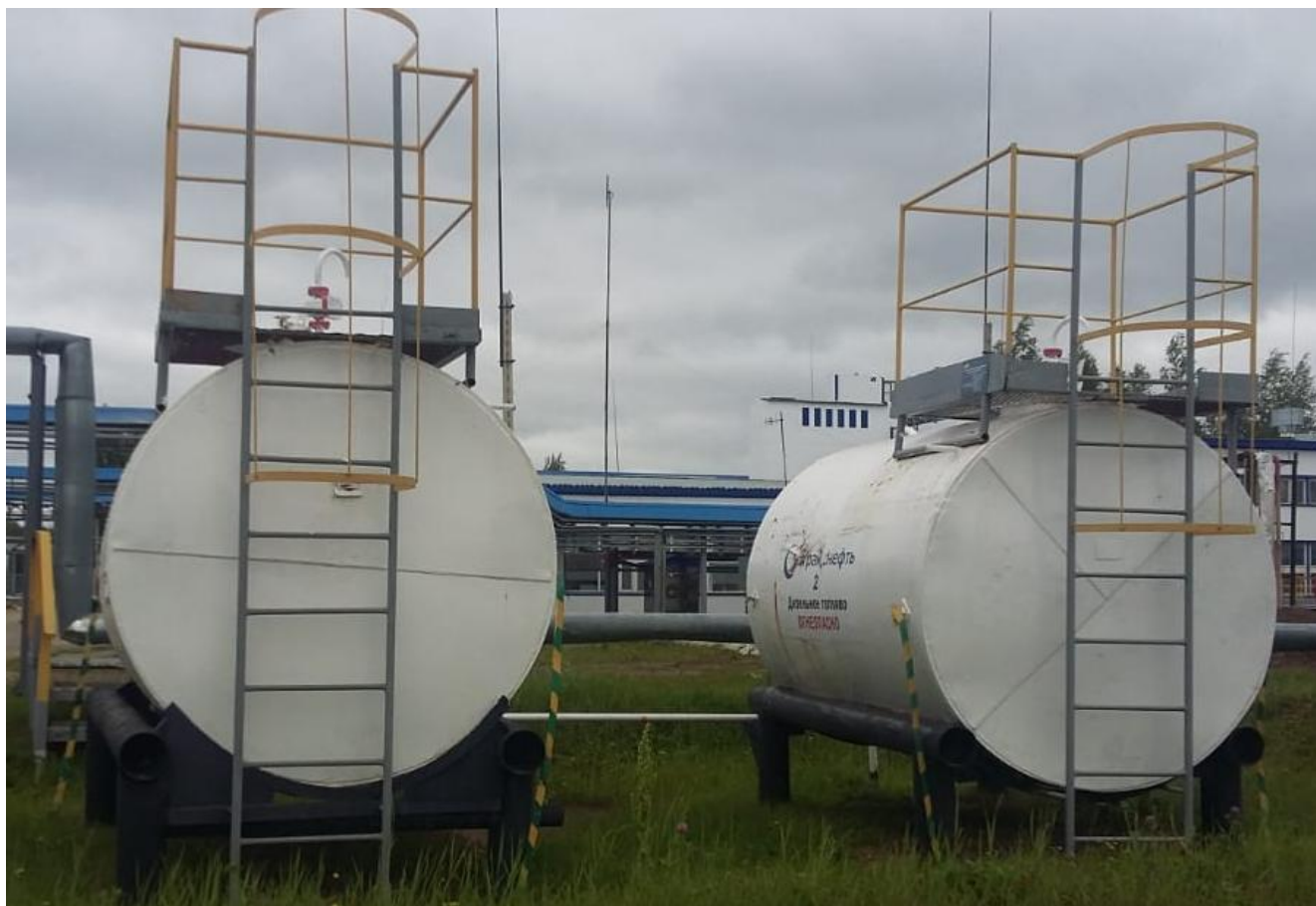
Рисунок 1 - Общий вид резервуаров стальных горизонтальных цилиндрических РГС-10
