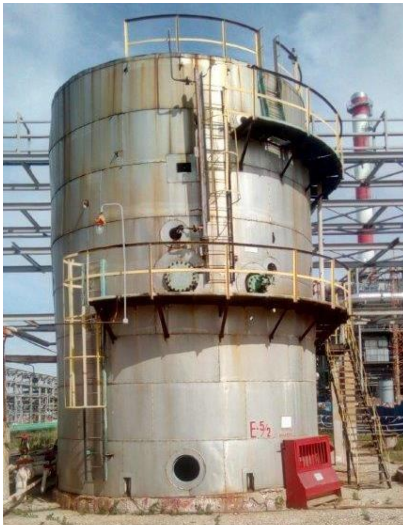
Рисунок 1 - Общий вид резервуара стального вертикального цилиндрического РВС-300
