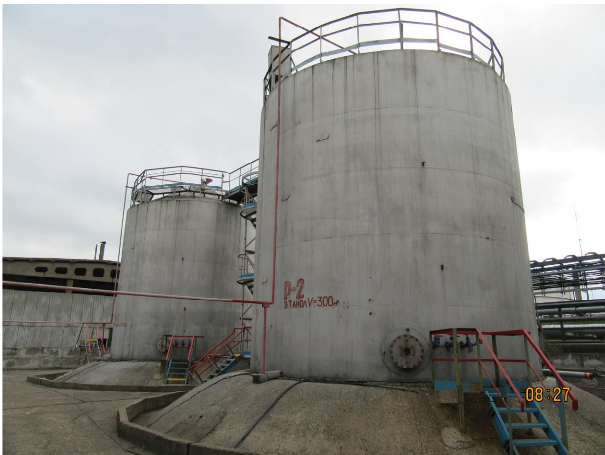
Рисунок 1 - Общий вид резервуаров стальных вертикальных цилиндрических РВС-300
