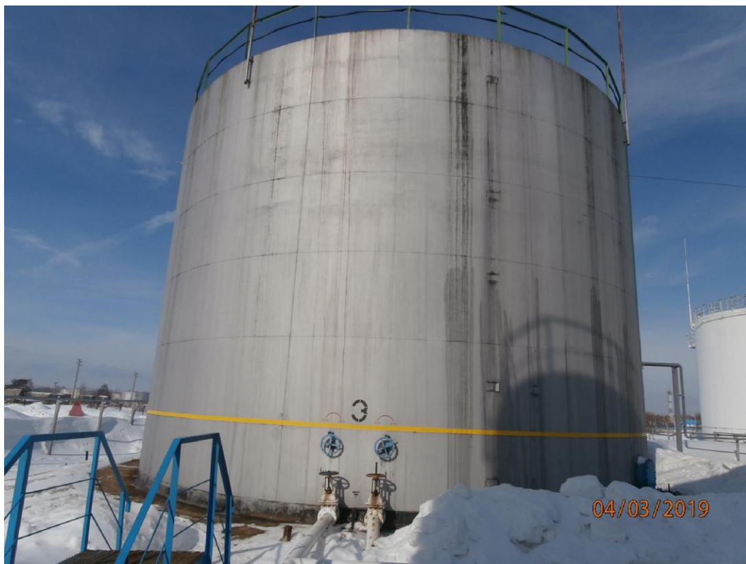
Рисунок 1 - Общий вид резервуара вертикального стального цилиндрического РВС-1000,
