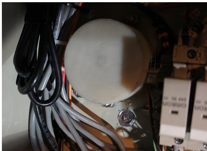
Рисунок 7 –Пломбирование преобразователей температуры PR, ПСТ, ИП 0304/МЗ-Н
