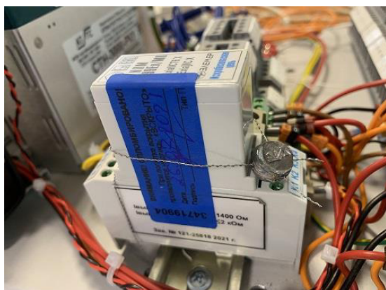
Рисунок 5 – Пломбирование преобразователя измерительного модульного ИПМ 0399
