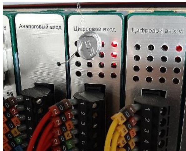
Рисунок 4 – Пломбирование платы аналогового входа контроллера
