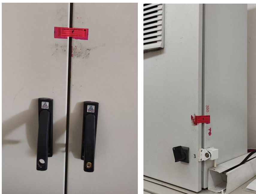
Рисунок 5 – Схема пломбировки шкафа программируемого контроллера Simatic S7-400 от несанкционированного доступа
