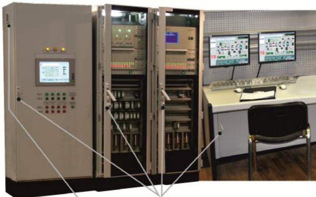
Рисунок 1 – Фото общего вида с указанием места пломбирования и нанесения знака поверки
