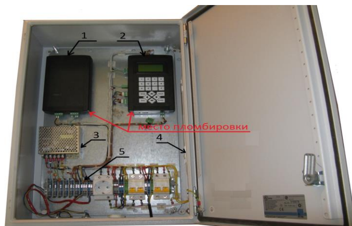
Рисунок 1 - Общий вид блока измерительного ИС-14.М 1 - вычислитель; 2 - контроллер ИС-14.М; 3 - источник питания; 4 - лампа освещения; 5 - клеммная колодка
