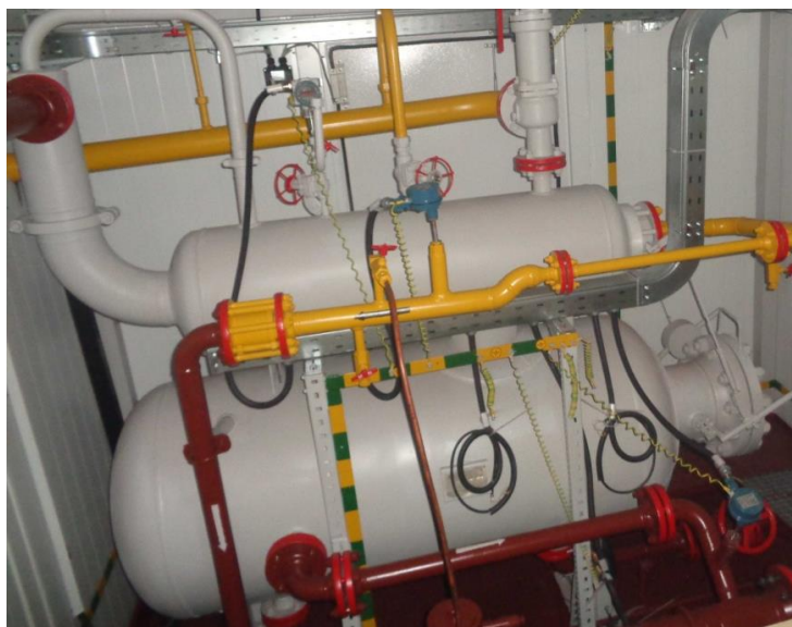
Рисунок 2 – Установка измерительная «МЕРА-ММ.ХХХ». Общий вид. Блок технологический сепарационный.
