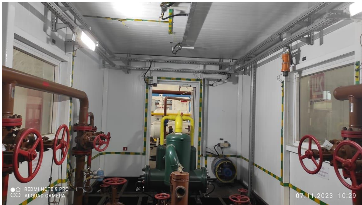
Рисунок 3 – Установка измерительная «МЕРА-ММ.ХХХ». Общий вид. Блок технологический бесепарационный.
