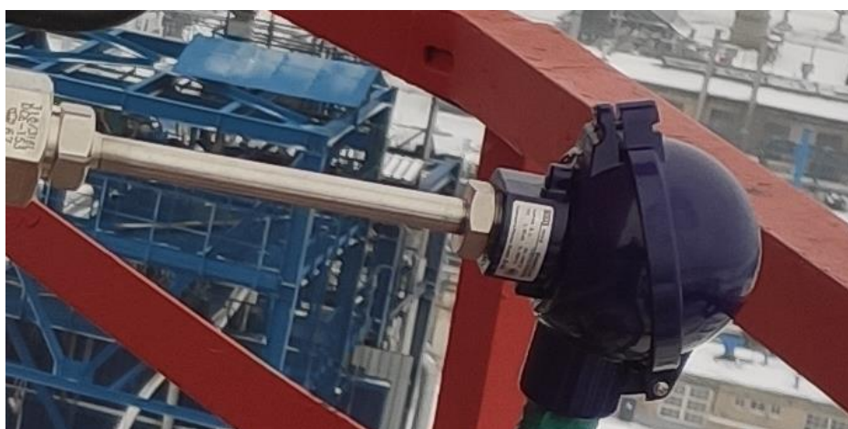
Рисунок 3 – Общий вид термопреобразователя сопротивления серии TR модель TR10-B
