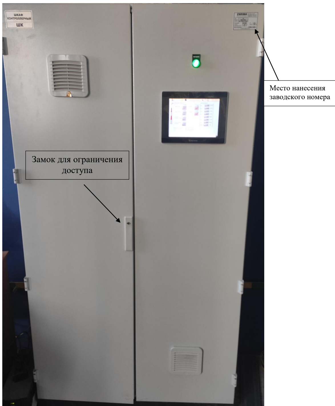
Рисунок 5 – Общий вид контроллерного шкафа
