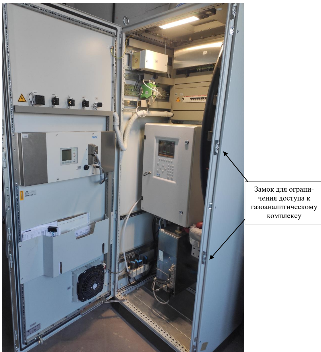
Рисунок 1 – Общий вид комплекса газоаналитического MCS модификации MCS 100 E HW
