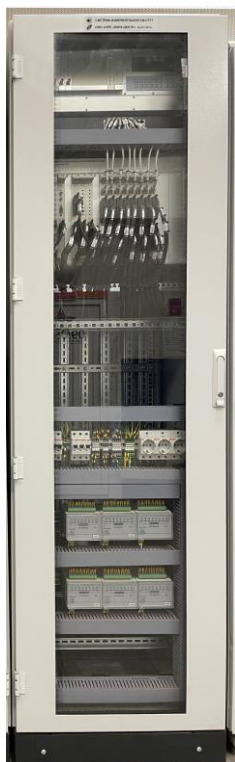
Рисунок 2 - Шкаф измерительного оборудования
