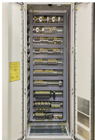
Рисунок 3 – Шкаф соединительный (в открытом виде)
