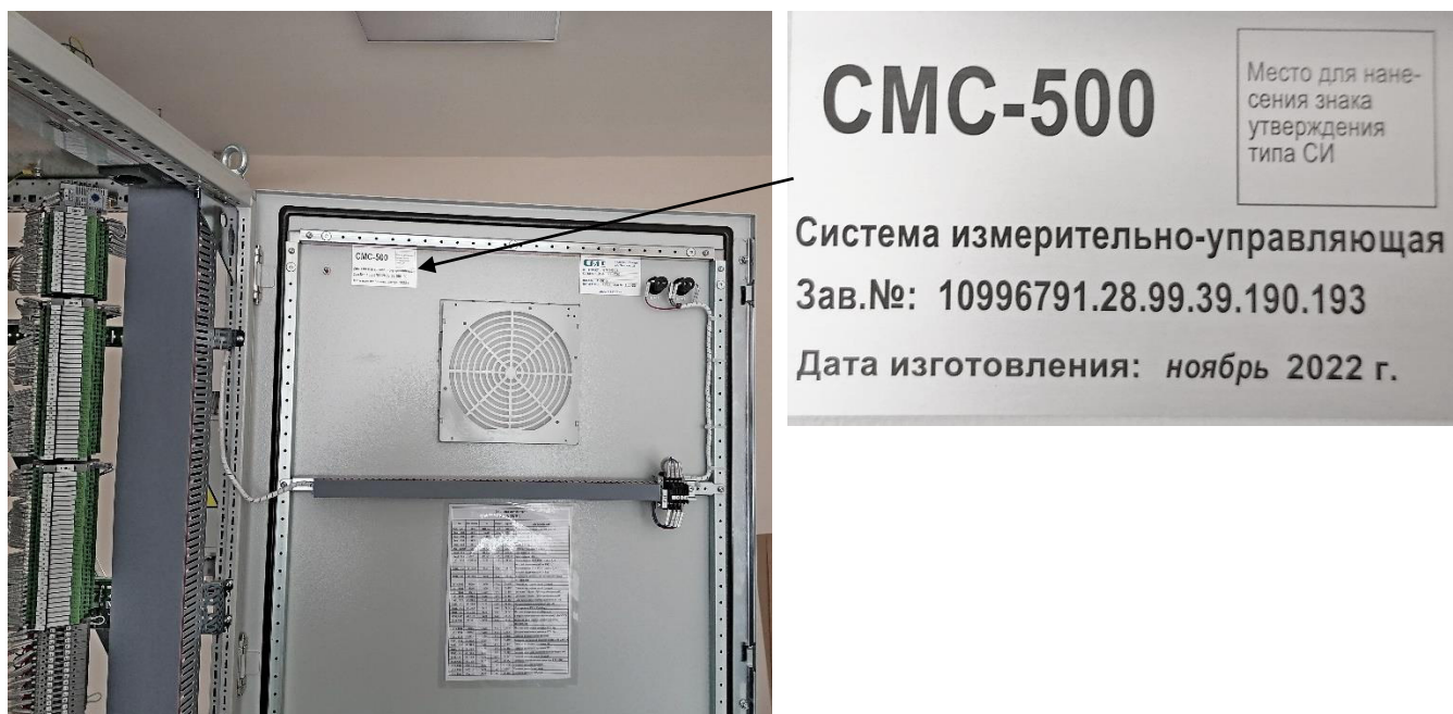
Рисунок 2 – Способ нанесения заводского номера
