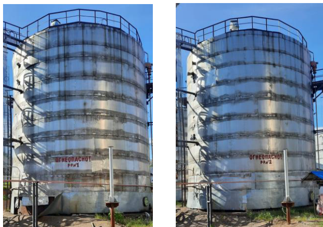
Рисунок 1 - Общий вид резервуаров стальных вертикальных цилиндрических РВС-1000
