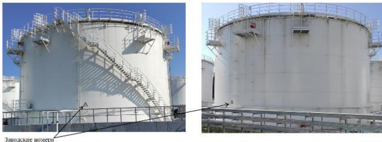
Рисунок 1 – Общий вид резервуаров стальных вертикальных цилиндрических РВСП-5000 с указанием мест нанесения заводских номеров.
