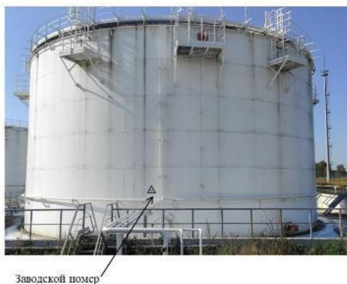
Рисунок 1 – Общий вид резервуара стального вертикального цилиндрического РВСП-5000 с указанием места нанесения заводского номера.
