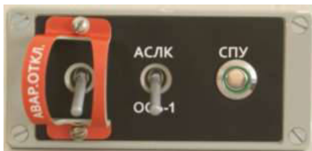
Рисунок 1.3.5 – Пульт аварийного отключения системы
