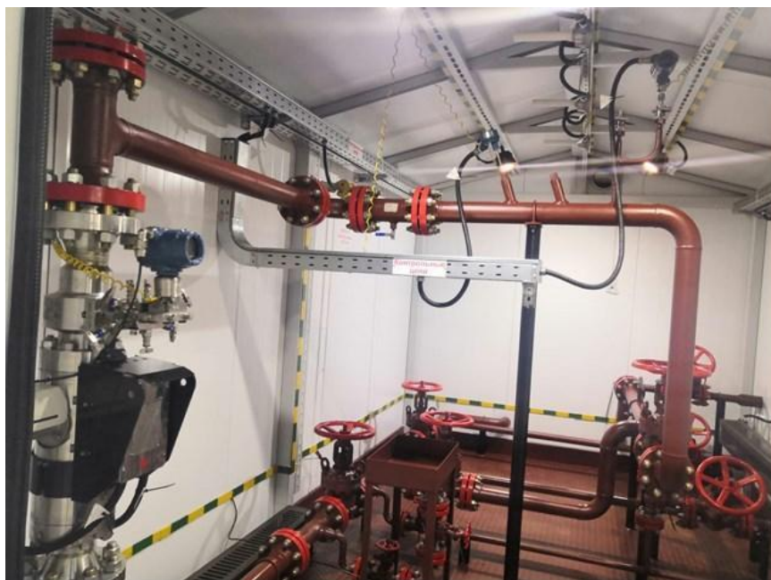
Рисунок 2 – Установка измерительная «Мера-МР». Общий вид. Блок технологический
