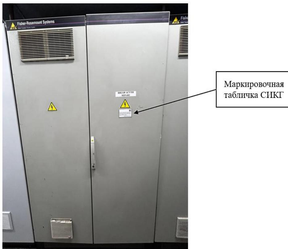
Рисунок 2 – Место установки маркировочной таблички СИКГ
