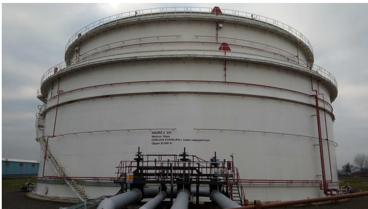
Рисунок 1 – Общий вид резервуара РВСПК-30000 зав.№ 231
