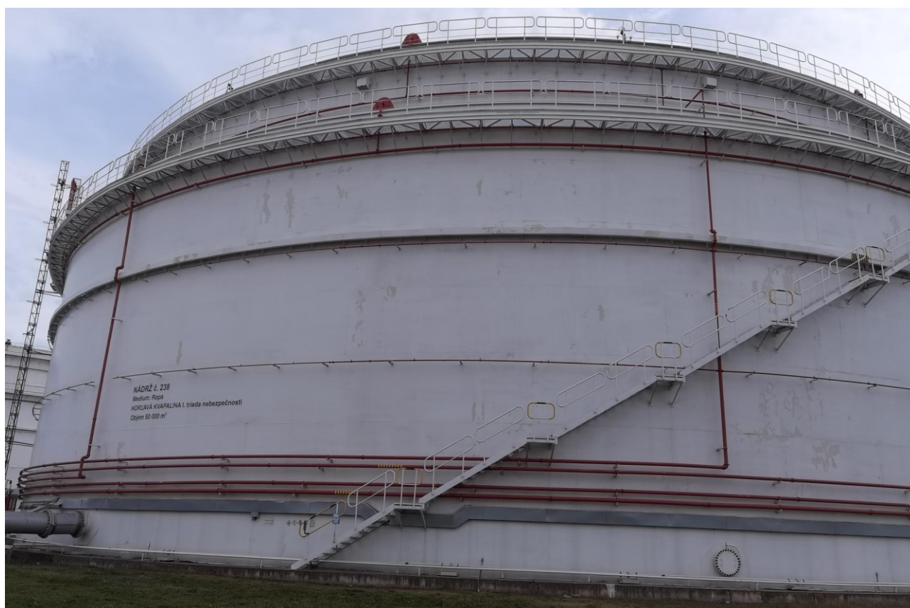
Рисунок 2 – Общий вид резервуара РВСПК-50000 зав.№ 238
