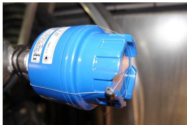
Рисунок 13 – Пломбирование датчика температуры
