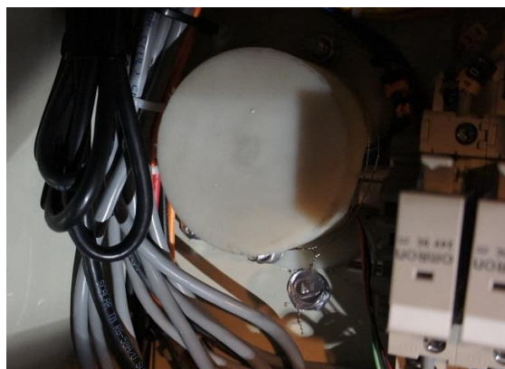
Рисунок 12 – Пломбирование преобразователей температуры PR, ПСТ, ИП 0304/МЗ-Н
