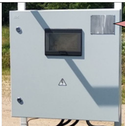
Рисунок 1В – Внешний вид БИНУС с внешней металлической дверцей с установленным на ней монитором
