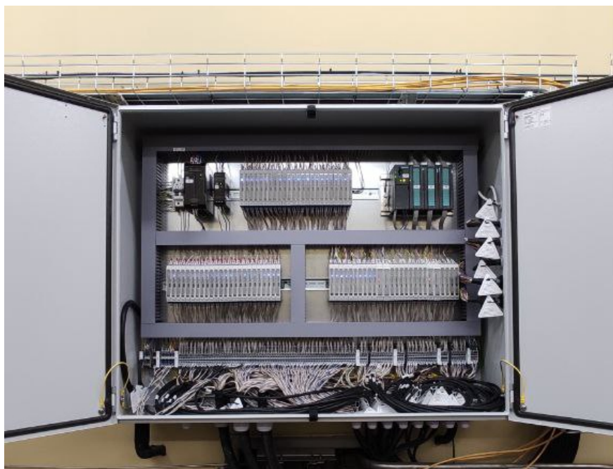
Рисунок 1 – Общий вид шкафа управления системы
