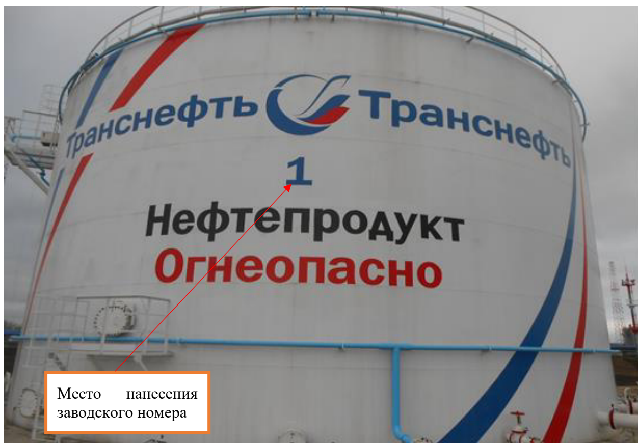
Рисунок 1 – Общий вид резервуара стального вертикального цилиндрического РВСП-5000 и место нанесения заводского номера
